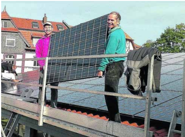
Montage der ersten PV-Anlage der Energiegenossenschaft auf den Dächern des Gesellschaftsraums und der Gemeindebücherei in Oberkaufungen. (Foto: privat)
